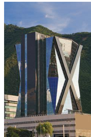
Torre XI, Monterrey, N.L.
