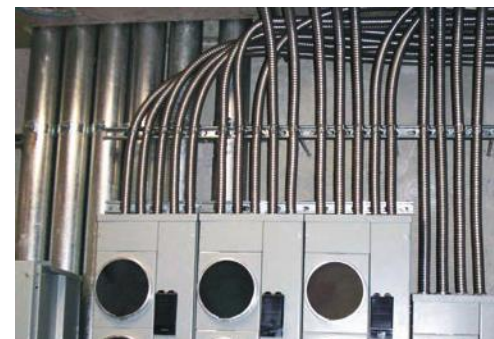
Instalación de cable tipo MC en concentración de medidores
